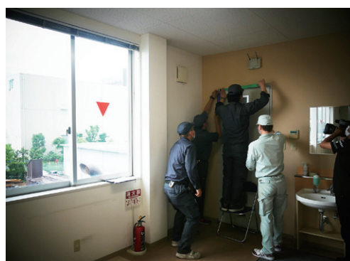
【一時避難スペースにおける扉の隙間の目張り】
